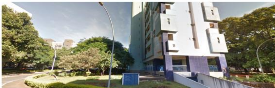
Imagem lateral do prédio
